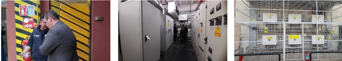
Resim 13: İç Alan ve Dış Alanda Kilitli Ayrı Bölümlerde Bulunan İnvörtörler
